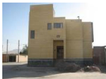
شکل ۷) نمایی از ساختمان‌های اسکلت فلزی (واحد ۵)
