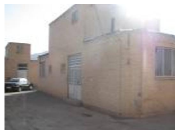
شکل ۵) نمایی از ساختمان‌های آجری بدون شناژ (واحد ۳)
