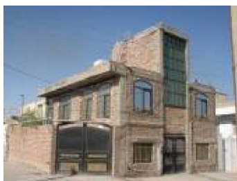
شکل ۶) نمایی از ساختمان‌های آجری شناژدار (واحد ۴)
