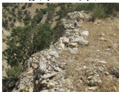
ب) بقایای دیوار ضلع شمالی قلعه عاشقونه
