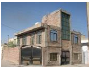
شکل (۶) نمایی از ساختمان‌های آجری شناژدار (واحد ۴)
