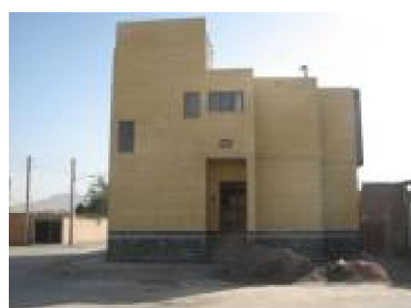
شکل (۷) نمایی از ساختمان‌های اسکلت فلزی (واحد ۵)
