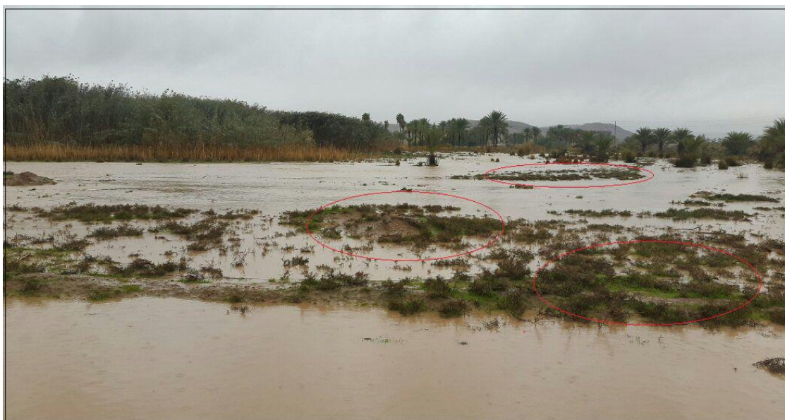
شکل ۸- افزایش گل آلودگی آب رودخانه و عریض شدن بستر
