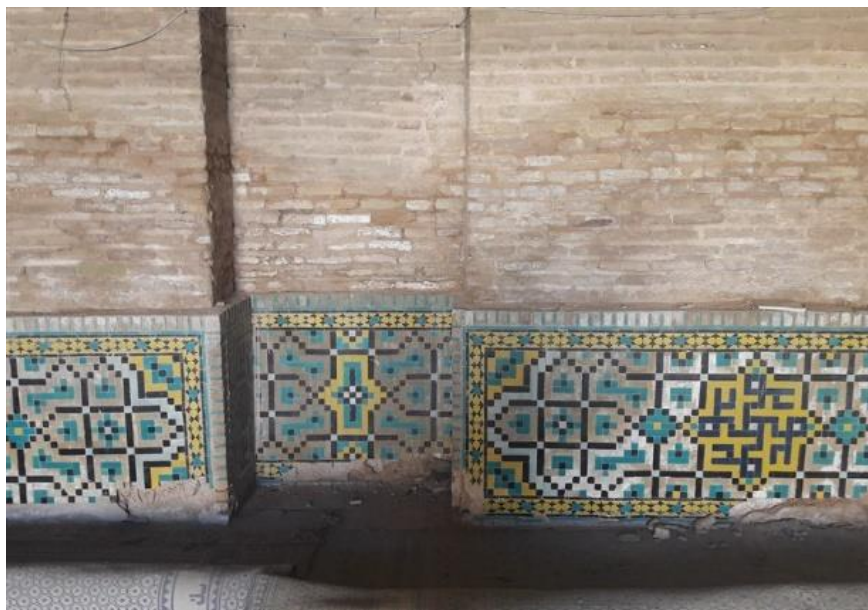
شکل ۴) متورم شدن دیوار شبستان مسجد تاریخی آقانور در اثر رطوبت در سال ۱۳۹۵
