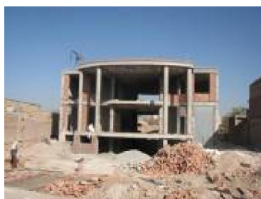
شکل ۸) نمایی از ساختمان‌های بتنی (واحد ۶)
