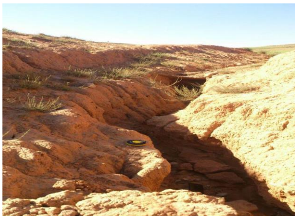
شکل ۷- نمونه‌ای از خندق‌ها در اثر فروریختن سقف تونل
